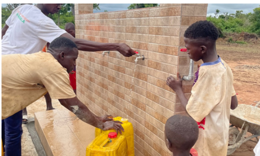
Premiers litres d'eau potable à Nambékaha
